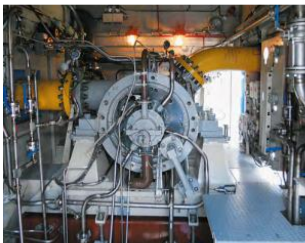
Рисунок 1.3 – Центробежный компрессор 170-31-1С
